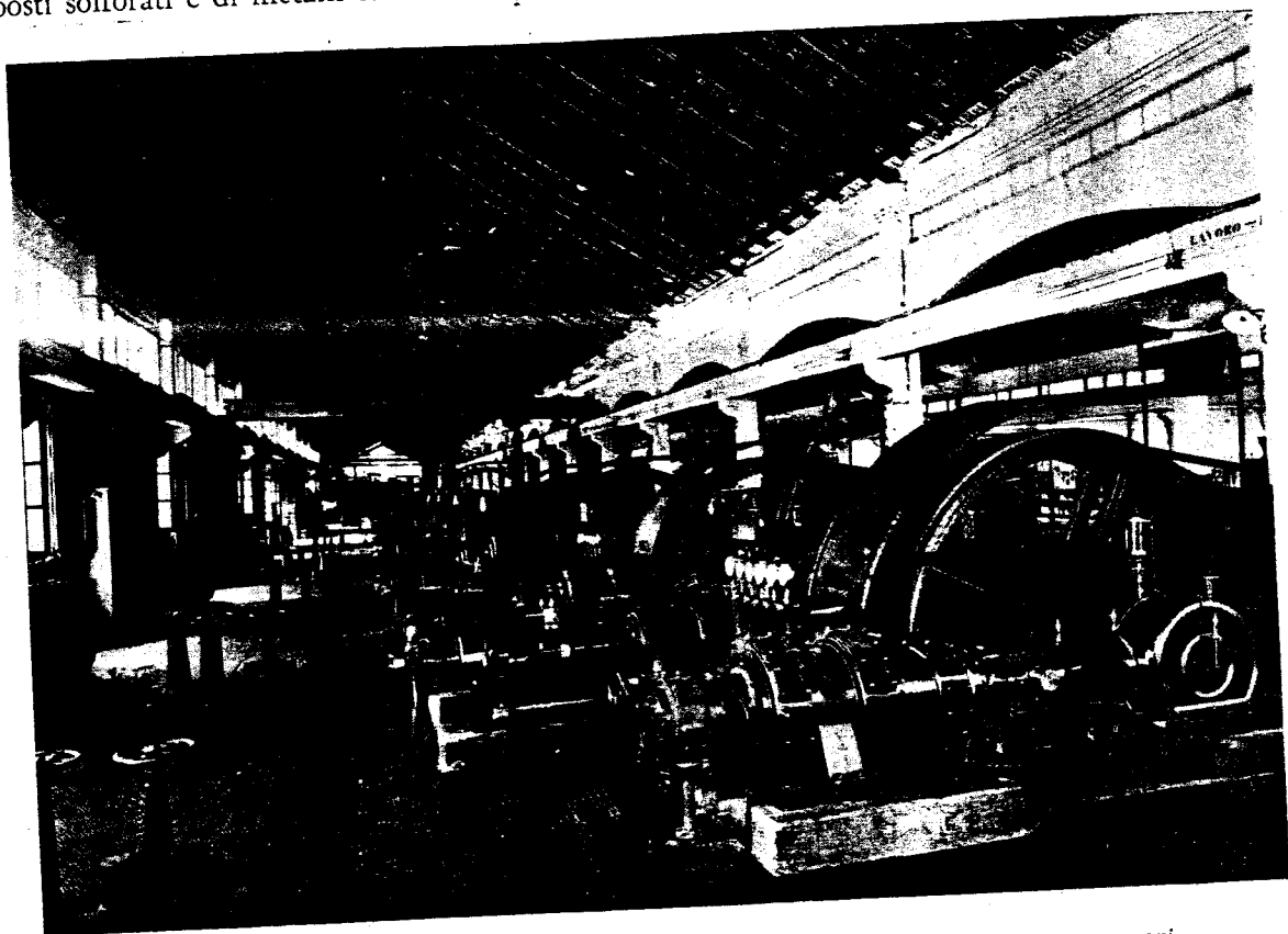
Società Terni - Nera Montoro. Impianto per la sintesi del metanolo. Sala compressori.
